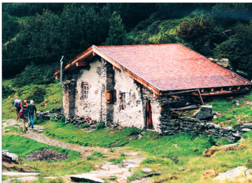
Symbol der Zusammenarbeit: Das alte Winterhaus am Zugangswege zur Berliner Hütte. Gleichfalls unter Denkmalschutz stehend, wird es von der Sektion Zillertal in Stand gehalten Foto Friedrich Christopher
