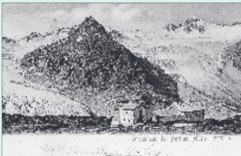
Der Bauzustand des Jahres 1898. Links Hornkees und rechts Waxeggkees. Archiv der Sektion Berlin
