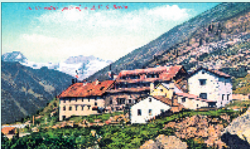
Seit 1912 erhebt sich das „Haupthaus“ als zentraler Bau der Berliner Hütte. Foto Sammlung Fam. Schünke
