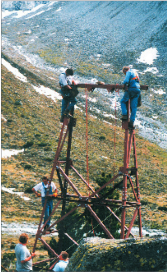
Mastmontage an der 1998 in Betrieb genommenen Materialseilbahn. Foto Manfred Gruber
